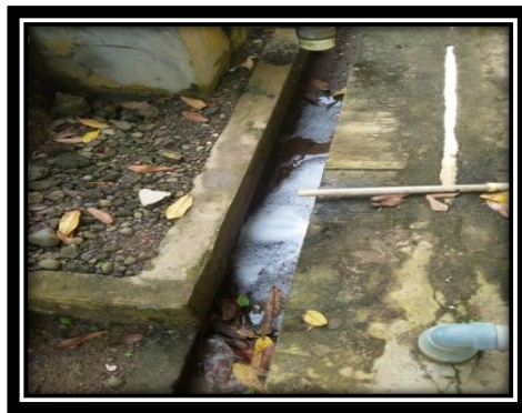
SPAL (Saluran Pembuangan Air Limbah)
