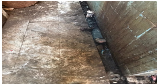
Saluran Drainase Pasar Panorama
