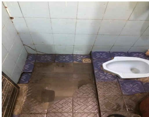
Toilet Pasar Panorama
