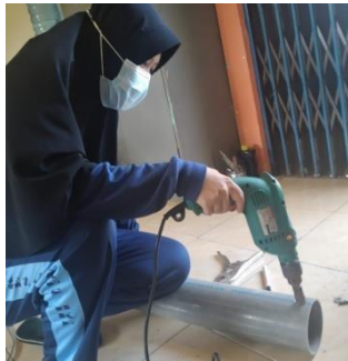
Pelubangan untuk tempat kran
